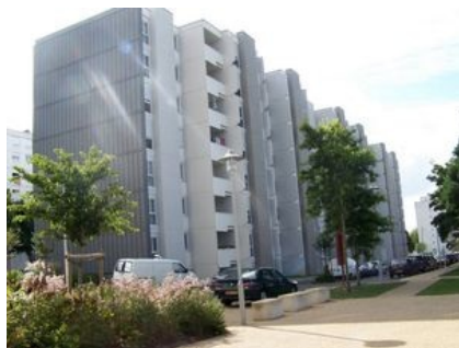
Immeuble du Ponant en 2009
