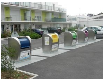
Les conteneurs enterrés
