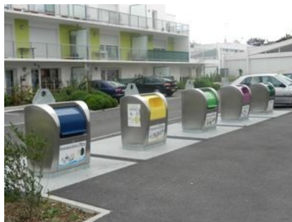
Les conteneurs enterrés
