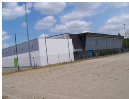
Le gymnase après les travaux
