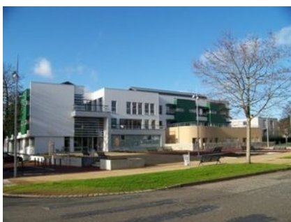
EHPAD, vue d'ensemble
