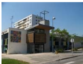
L'entrée du bâtiment rue Maurice Thorez
