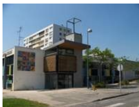
L'entrée du bâtiment rue Maurice Thorez
