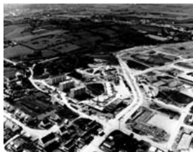
Vue aérienne construction de la ZUP
